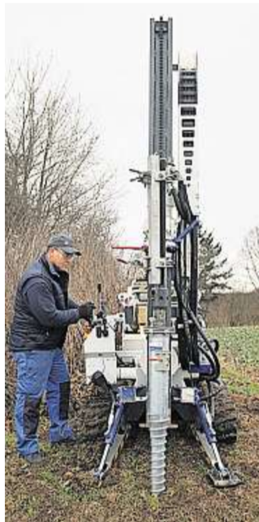
Der Bohrer für die speziellen Fundamente wird angesetzt.
