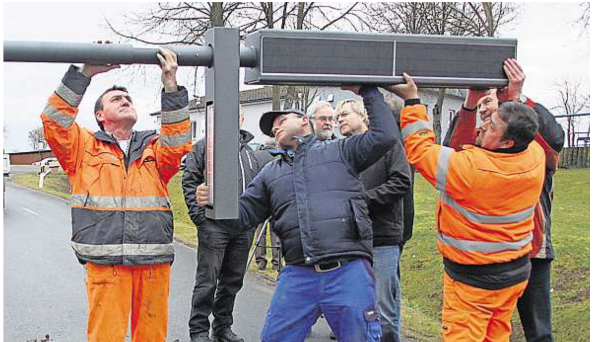
Gemeinsam wurden die netzunabhängigen Straßenleuchten aufgestellt.
